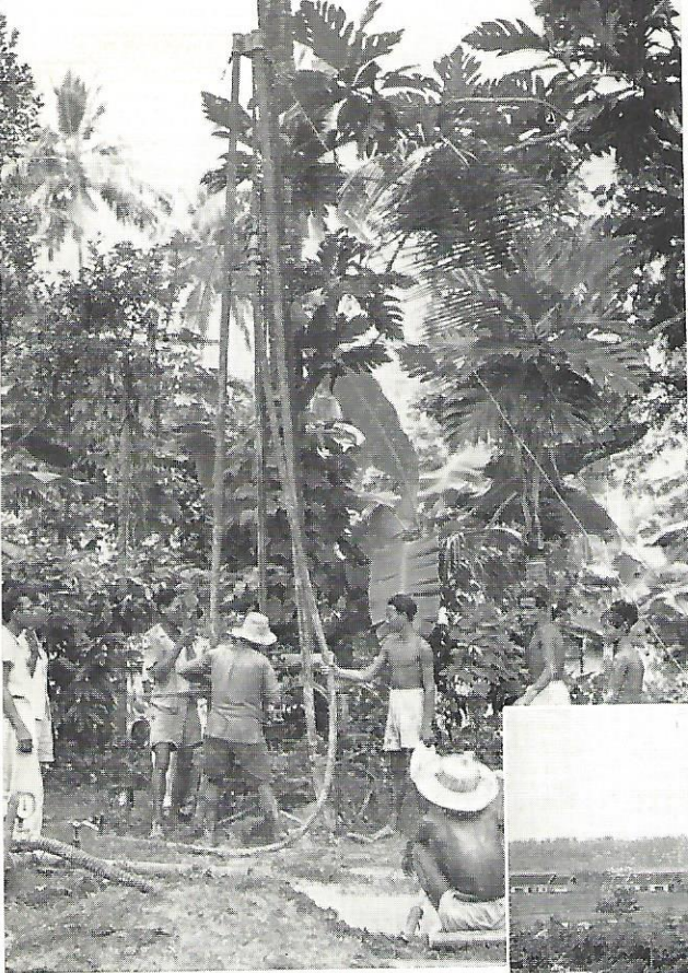
Seismisch onderzoek op het eiland Madura. Een schietgat wordt geboord.
